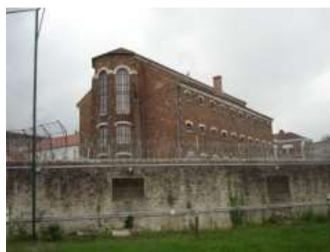
Ancienne Maison d'Arrêt
