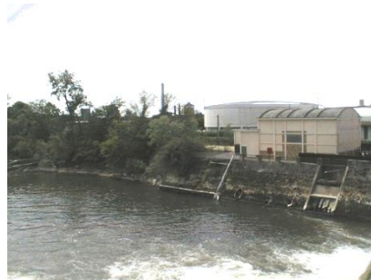
La station d'épuration
