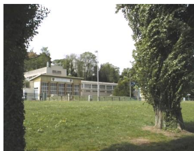
L'usine des eaux
